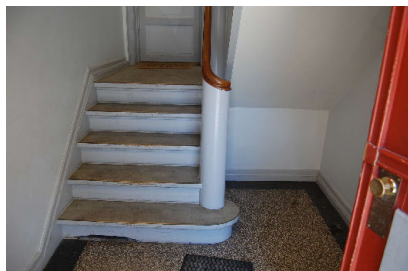
På hovedtrapper skal etableres ny adgang til kælder
