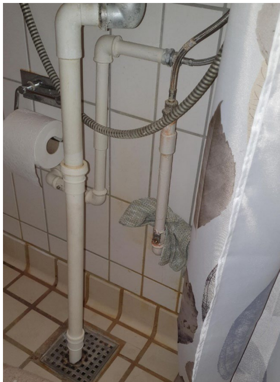
Foto 60. Brugsvandsrør til håndvask. Rørene kommer fra naboeligheden.
