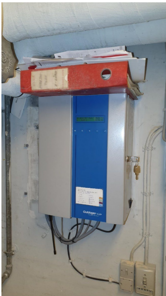
Foto 43. Guldager elektrolyseanlæg.
