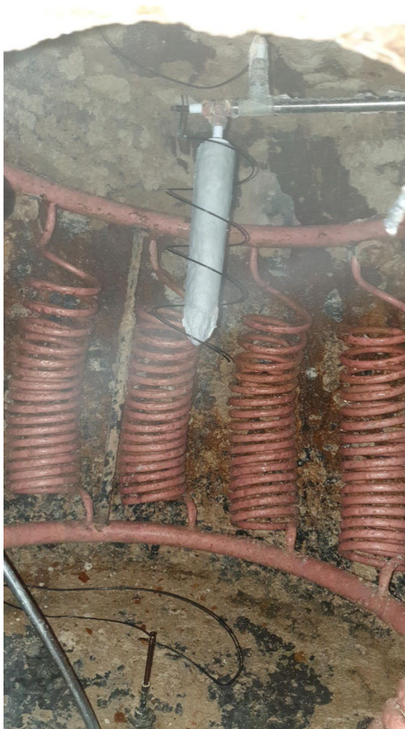
Foto 44. Indvendigt i en rensed beholder. I midten hænger offeranoden.
