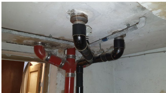
Foto 19. Faldstamme i kælderen. Afløb fra WC og gulvafløb i badeværelse. Der er nyere gulvafløb og hovedstamme.
