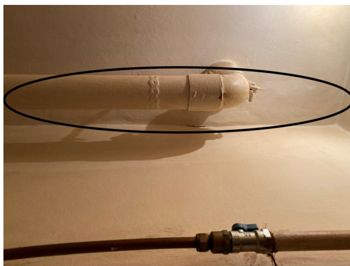
Foto 2. Revnemønster på loft i baderum der kunne indikere et rustangreben bærejern.
