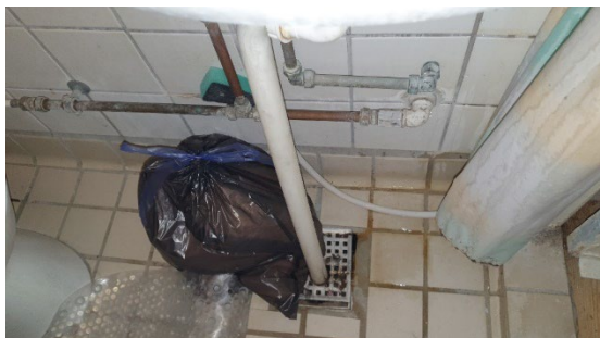
Foto 31. Gulvafløb i badeværelse med nyere gulvbelægning.
