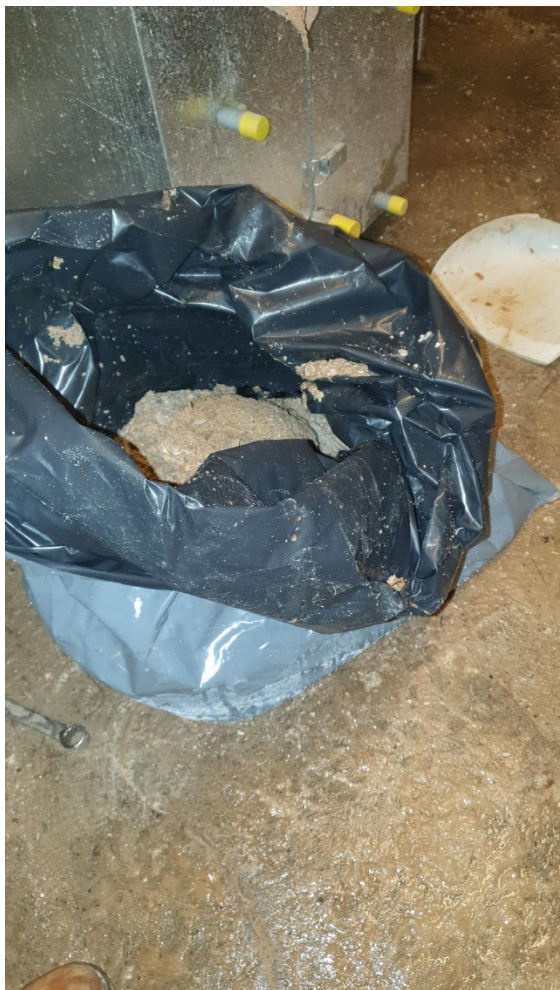
Foto 45. Kalkaflejringer fra varmtvandsbeholderen efter 1 år.
